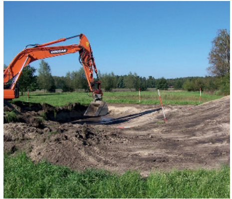
Erster Tag: Bagger beim Bodenaushub
