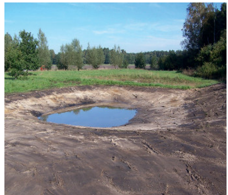
Zweiter Tag: Fertiges Gewässer, mit Grundwasser gefüllt
